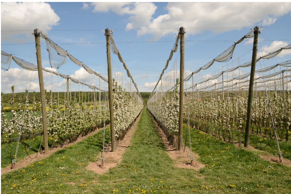
Obrázek 2. Čelní pohled na vybudovanou konstrukci.
